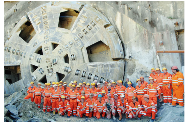
Mit der riesigen Tunnelfräse: Am 8. Mai 2008 wird der Durchstich der talwärts führenden Tunnelröhre gefeiert. Bilder: Stéphane Gerber
